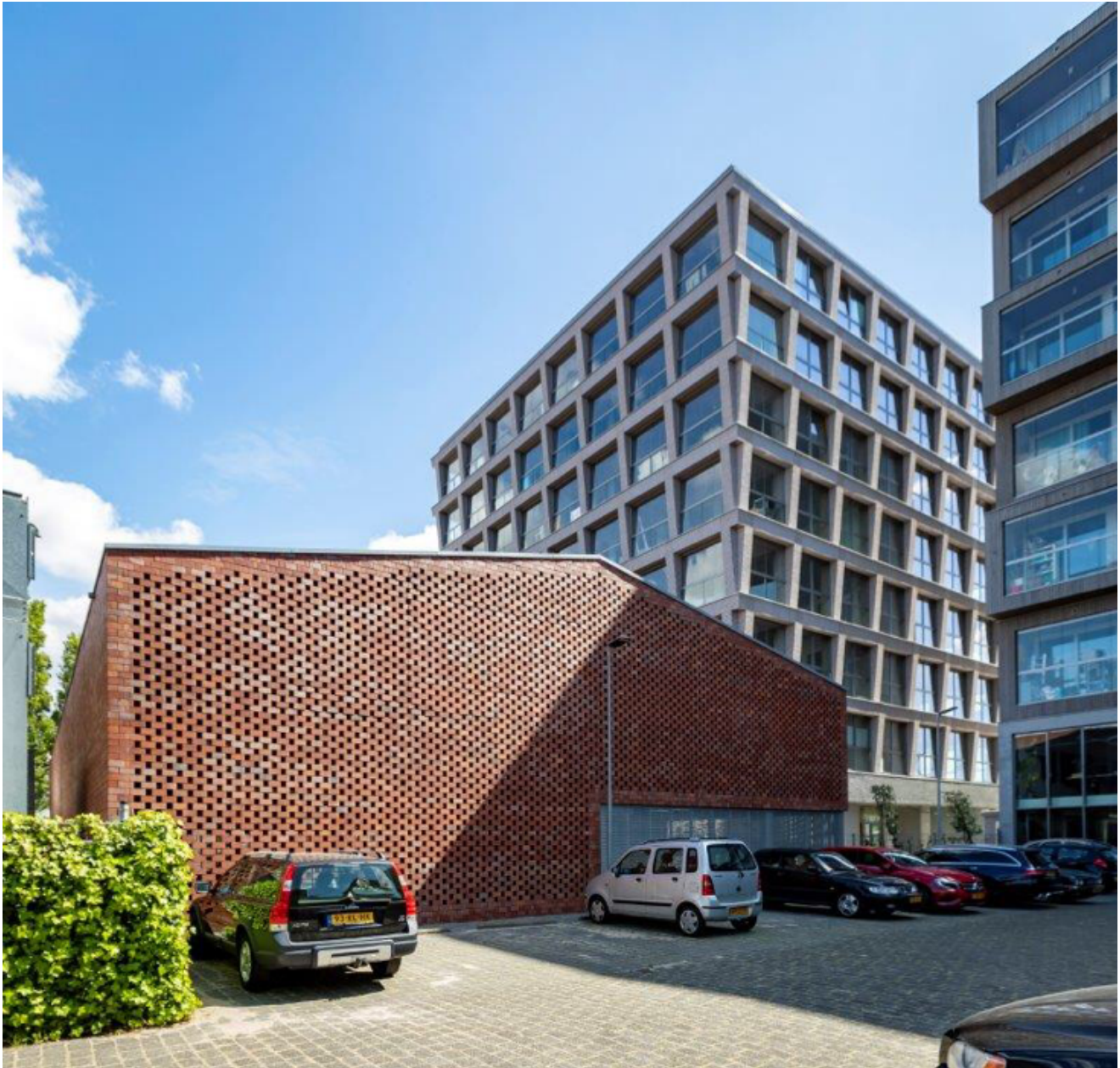
Achter het gebouw bevindt zich een tweelaagse beveiligde parkeergarage met 48 parkeerplaatsen. Beeld Isabel Nabuurs
