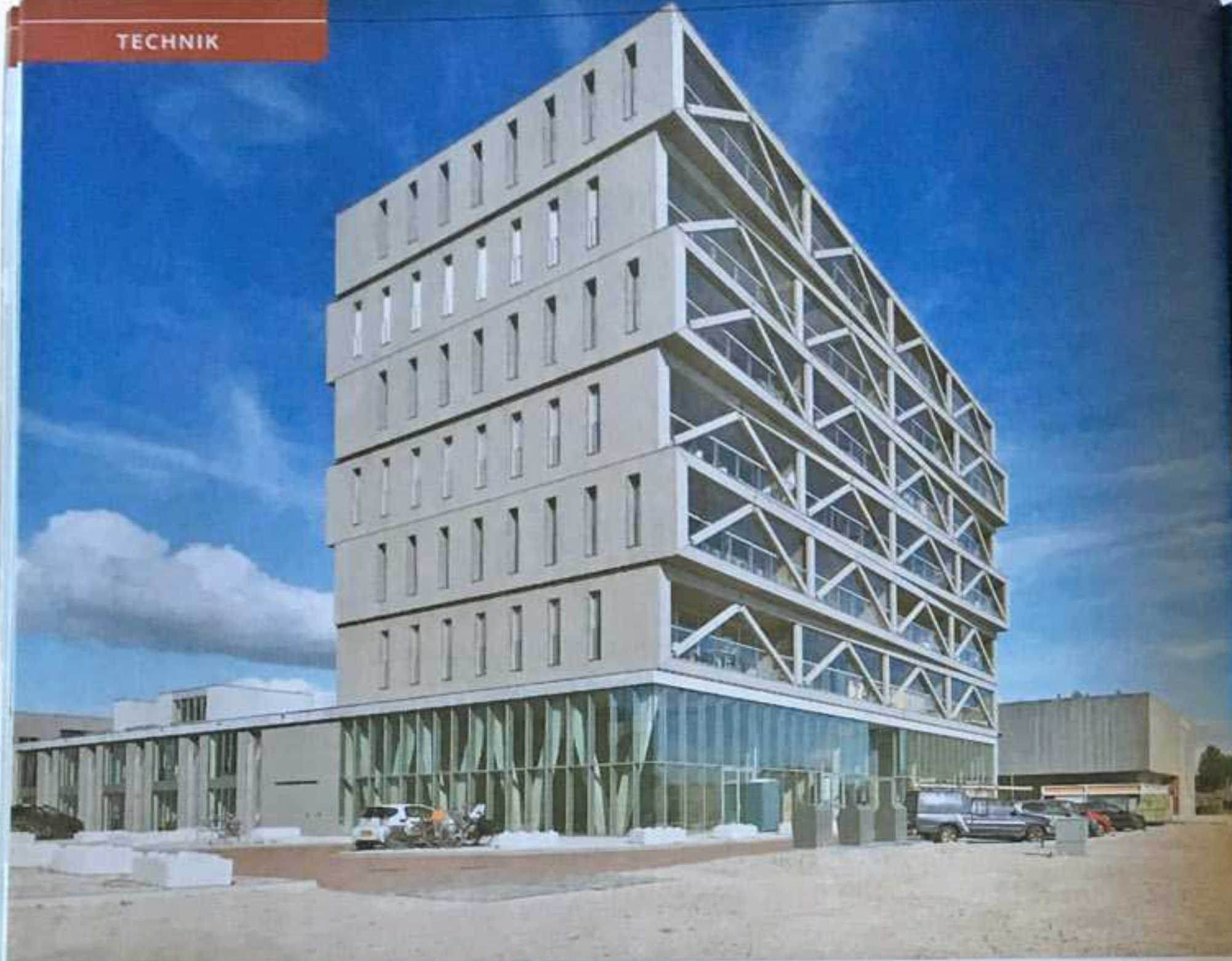
Anfangs war das Patch22 als reines Bürogebäude konzipiert, aber in Krisenzeiten sind Büroflächen nicht gefragt. Daher wurde umgeplant, und es entstanden 20 Prozent Büro- und 80 Prozent Wohnflächen auf sieben Geschossen.
