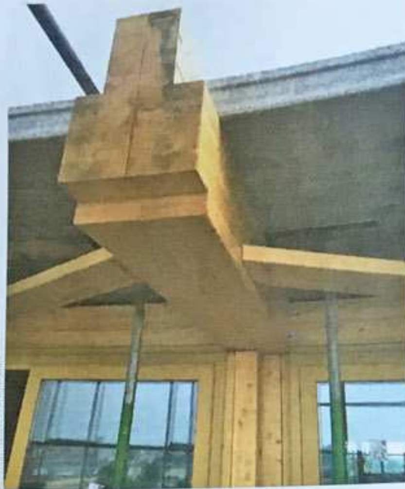
Das Tragwerk setzt sich aus hölzernen Stützen und auskragenden doppelten Brett-schichtholzträgern zusammen. Die Decken sind aus Stahlbeton und Stahlprofilen.
