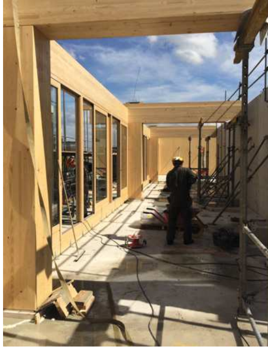
Hoofdconstructie van gelamineerd vuren kolommen en liggers, aan de kanaalkant ingevuld met Oregon pine schuifpuien.
